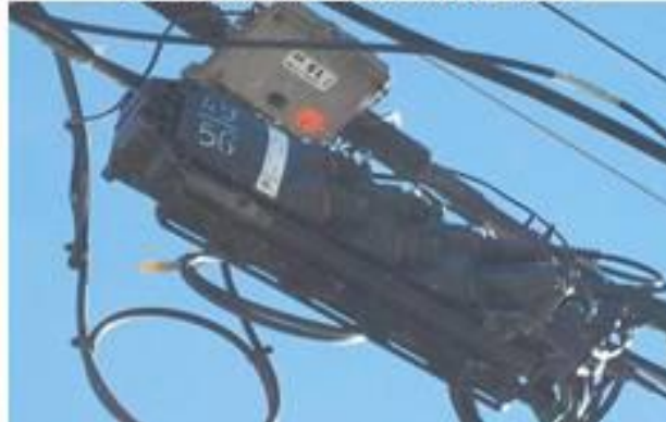
Caja Terminal aérea preconectorizada
